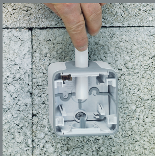
2/ Vložte trubku cez vytvorený otvor
