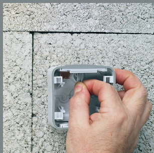
1/ Otvor urobíte zatlačením pomocou zakončovacieho nástroja
