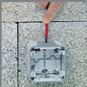
1/ Prepichnete membránu pomocou skrutkovača
